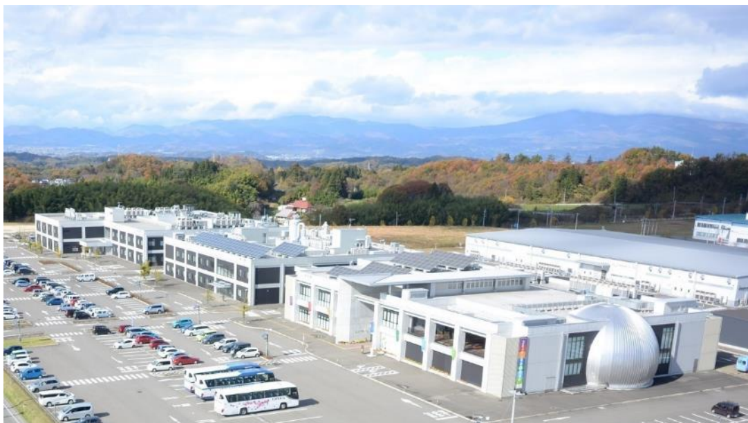
環境創造センター外観
