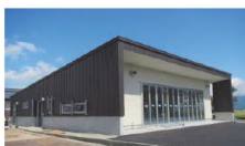
猪苗代水環境センター （猪苗代町）
